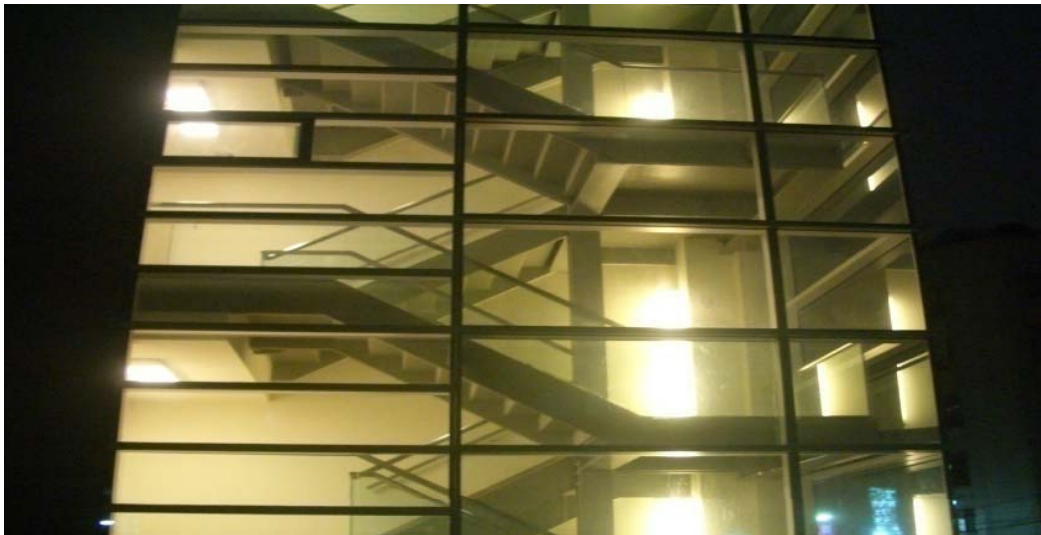
圖5-22》透明玻璃的樓梯間，可以提升使用者的安全感。
